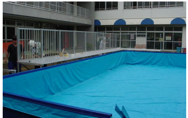
⑥内袋シートを敷いた後、プールサイドを組み立てる。
