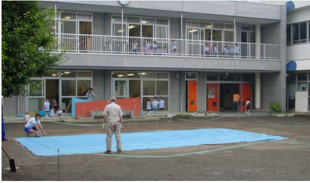
①内袋シートを保護するためのシートを敷く。
