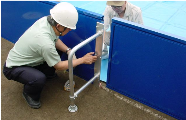
③側壁をボルトで固定する。
