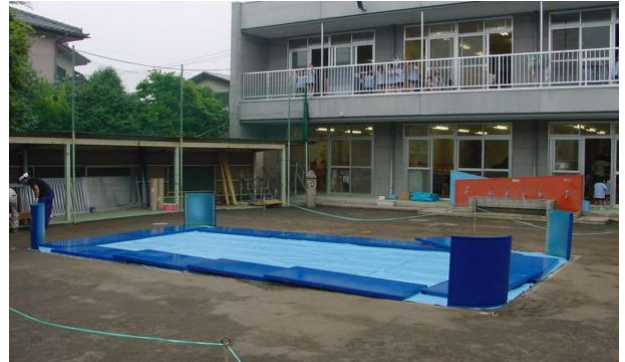
②側壁パネルを設置する。
