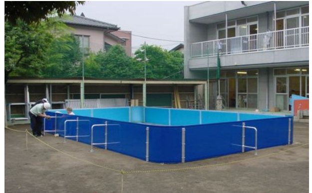
④側壁完成。
