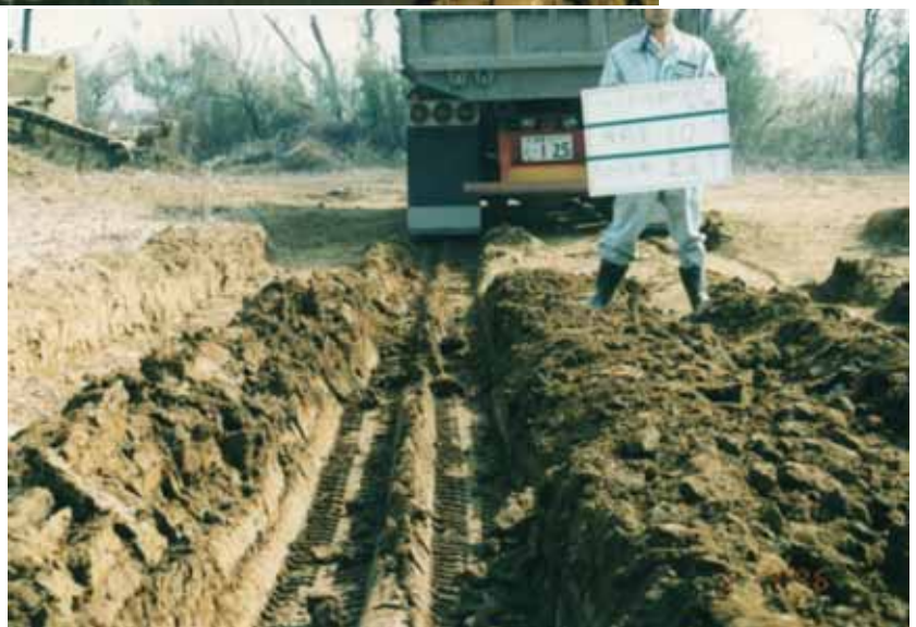
積載量 10 トン、車体総 重量 20 トンのダンプが 12 回走行後の路面
