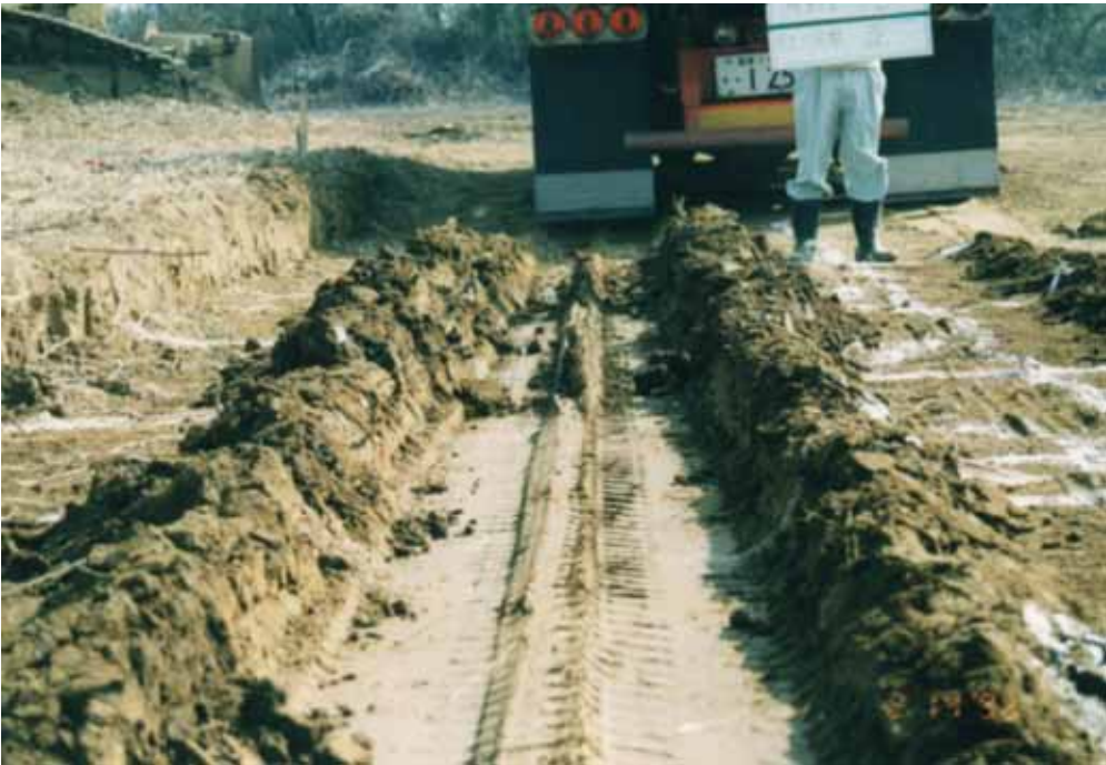
積載量10トン、車体総重量20トンのダンプが6回走行後の路面
